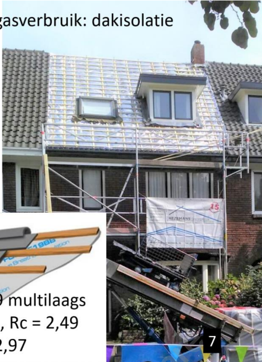
Fig. 7 Dakisolatie met SF19 multilaags folie tussen beschot en dakpannen.
